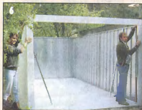
Теперь раму ворот наводят на боковые стены и крепят болтами. Для проверки прямоугольности гаража измеряют диагонали. Если они одинаковой длины, гараж собран правильно.
