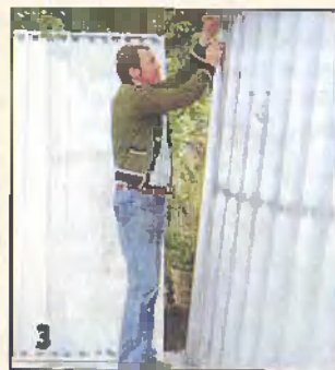
У заднего торца боковой стены привинчивают детали, которые служат для соединения боковых стен с задней.
