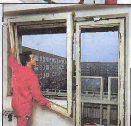
После удаления анкерных креплений выставляют из оконного проема подгнившую деревянную коробку окна.
