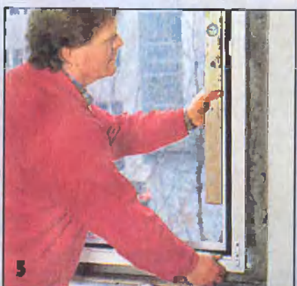
...временно крепят клиньями и выверяют по уровню.
