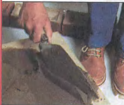
Плавными движениями отсекают кельмой порцию раствора (размером примерно с лопатку кельмы).
