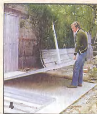
Затем приступают к сборке и установке второй боковой стены.
