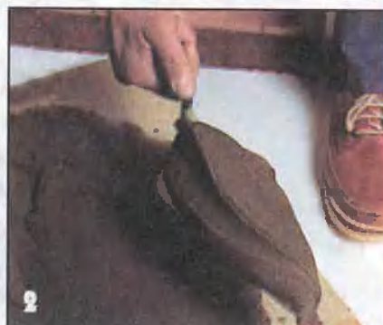
Придают порции раствора форму слегка изогнутого цилиндра, а затем резким движением берут раствор на кельму.
