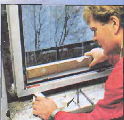
Чтобы коробка не провисала, под ее нижнюю обвязку подкладывают клинья.
