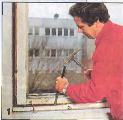
Прежде чем снять старую раму, удаляют прикрепленный к ней отлив.
