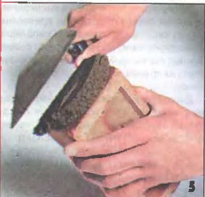
При кладке ложковых кирпичей встык раствор наносят на тычок, оттягивая кельму на себя.
