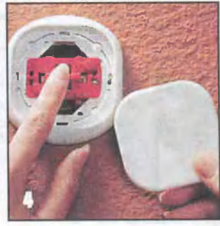
Выключатель вставляют в коробку в гнезде стены и разжимают боковые фиксаторы, затягивая установочные винты.
