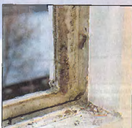
Как видно на фото, старая оконная коробка была прибита за откосом оконного проема.
