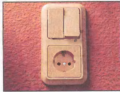
В комбинированных блоках в одном корпусе могут быть собраны до пяти выключателей и штепсельных розеток.
