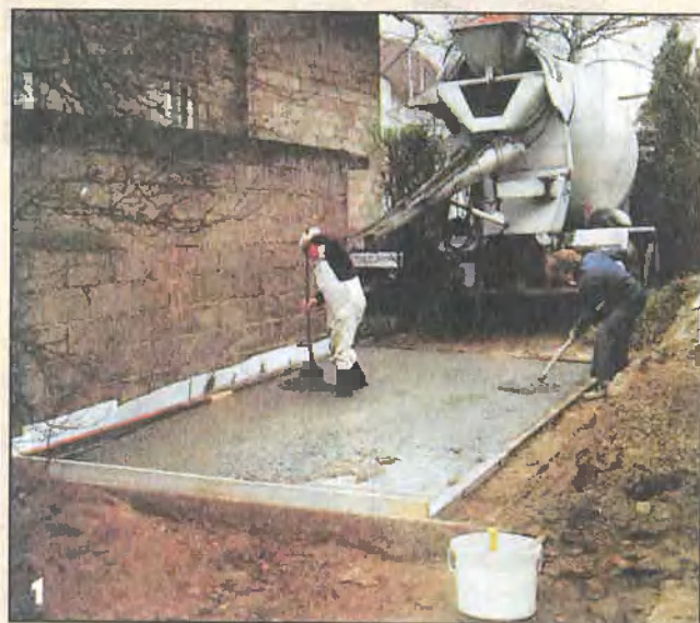
Фундаментом гаража служит отлитая из бетонного раствора плита, армированная проволоочной сеткой. Толщина плиты — 10 см.
