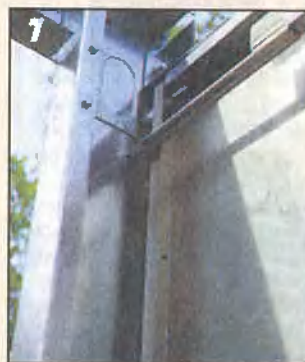
Боковая стена должна входить в раму ворот ровно на 5 см.
