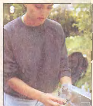
После этого монтируют уголки для крепления стропил.
