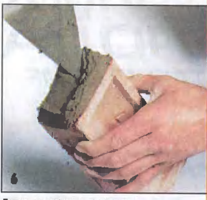
Держа кирпич вертикально, подрезают раствор на краях. Толщина слоя должна быть равномерной и составлять 10–12 мм.
