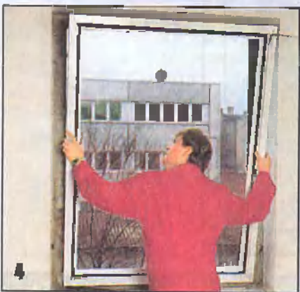
Новую оконную коробку устанавливают в оконный проем...
