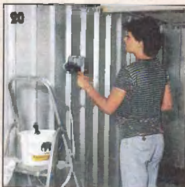
Пульверизатором на стену наносят грунтовку, а затем с помощью того же инструмента покрывают стены акриловым лаком или краской.
