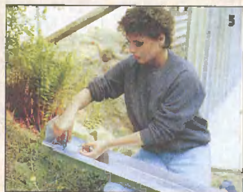
Теперь раму ворот наводят на боковые стены и крепят болтами. Для проверки прямоугольности гаража измеряют диагонали. Если они одинаковой длины, гараж собран правильно.
