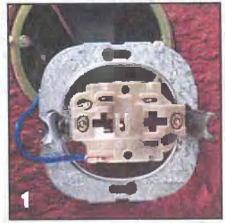
При подключении выключателя провода вставляют в клеммы и фиксируют винтами. Изоляцию на проводе снимают на длине 10–12 мм.
