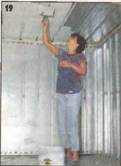
На потолок кистью наносят специальное покрытие, препятствующее образованию конденсата.
