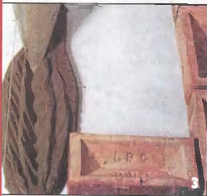
Рывками подают кельму назад, чтобы раствор лег на площадку в виде груши. Расстилают раствор, проводя острием кельмы по его середине.
